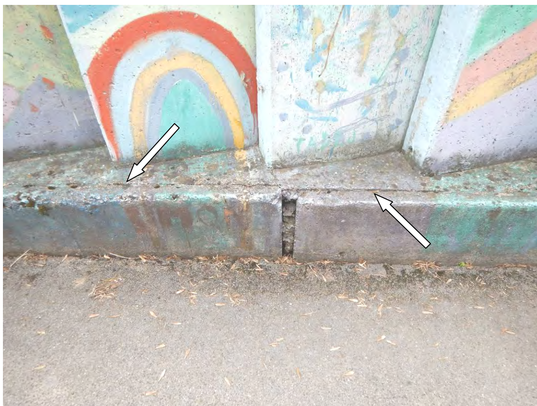
Slika 19: Vzdolž celotnega stika betonskega temelja in betonskih robnikov je viden odprt delovni stik povprečne širine ca. 1 cm
