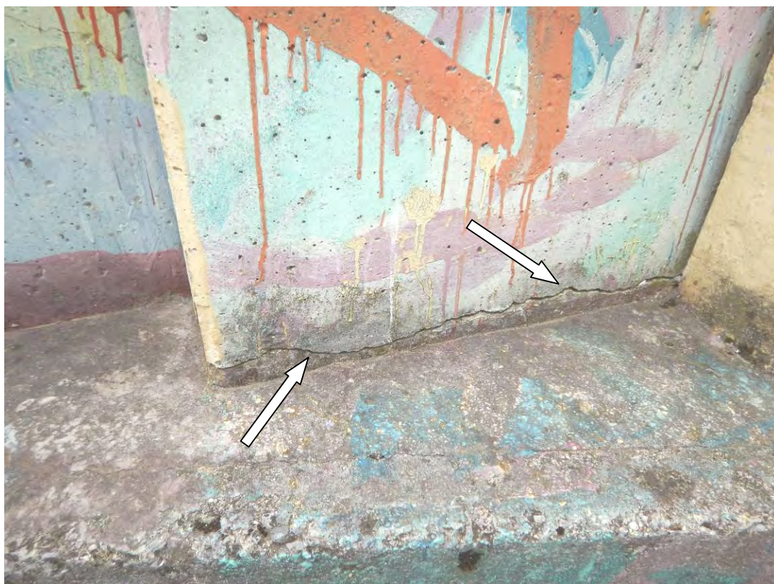
Slika 26: V območju določenih stikov AB elementov in betonskega temelja so vidne razpoke s horizontalno tendenco poteka (konstrukcijske poškodbe)
