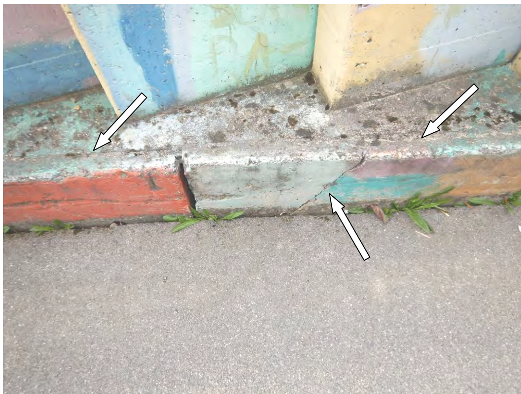
Slika 17: Na večih mestih so betonski robniki počeni oz. razpokani. Vzdolž celotnega stika betonskega temelja in betonskih robnikov je viden odprt delovni stik povprečne širine ca. 1 cm
