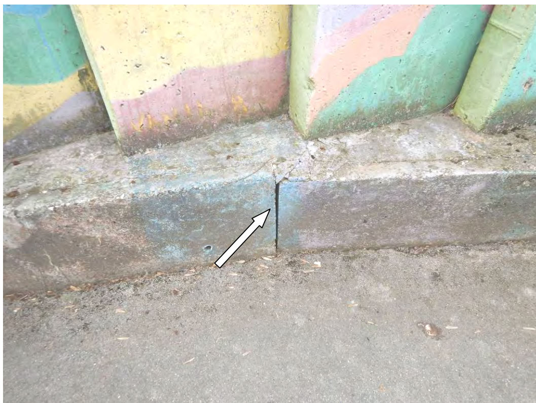
Slika 15: Vz dolž betonskega temelja, med betonskimi robniki, so vidni odprti stiki širine do max. 3 cm
