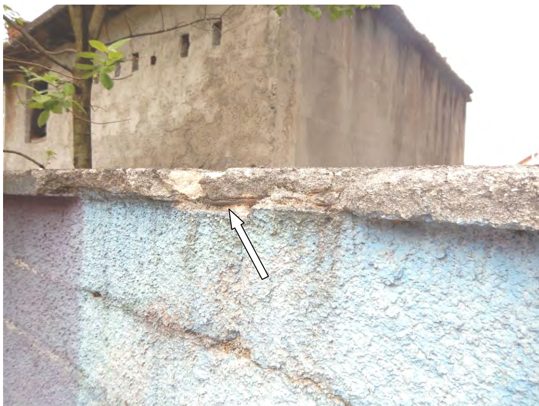
Slika 34: V območju stika zidane ograje in vrhnjega AB zaključka je vidna korodirana armatura. V tem območju je beton odlomljen in poškodovan
