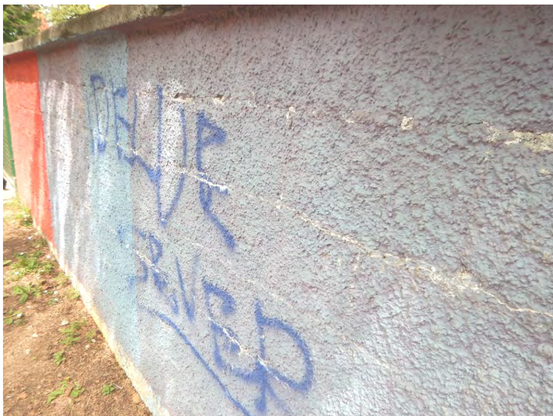
Slika 33: Na večjem delu zidane ograje je vidno odstopanje oz. odpadanje barvnega premaza v območjih fug med betonskimi zidaki. Mestoma je vidno tudi odpadanje veziva med betonskimi zidaki
