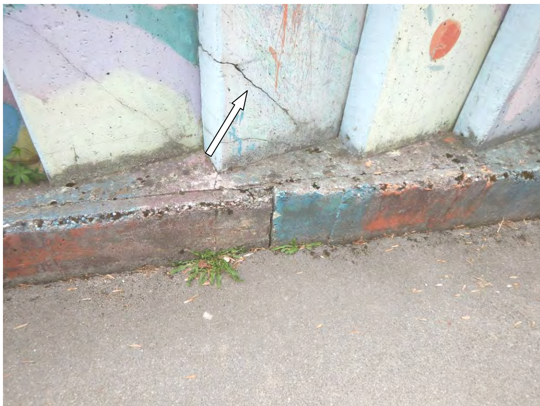
Slika 20: Na določenih AB elementih so prisotne konstrukcijske razpoke s horizontalno oz. diagonalno tendenco poteka
