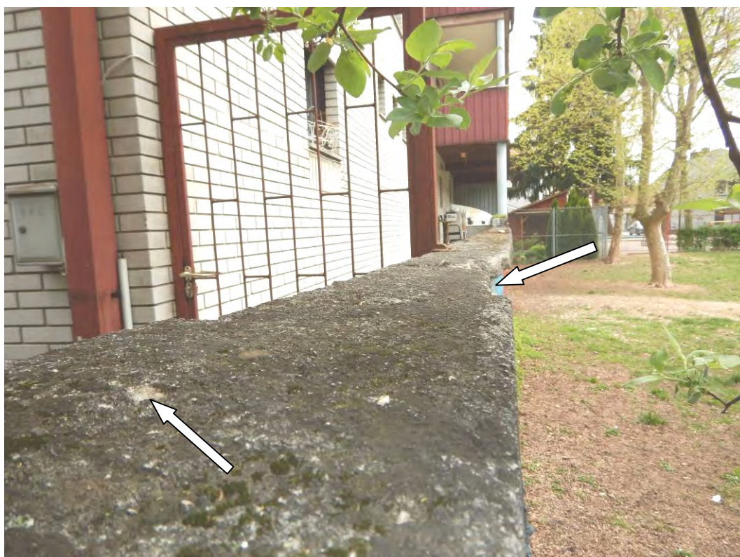
Slika 35: Na celotni površini vrhnjega AB zaključka je prisotno razraščanje vegetacije. Mestoma je beton tudi razpokan in poškodovan
