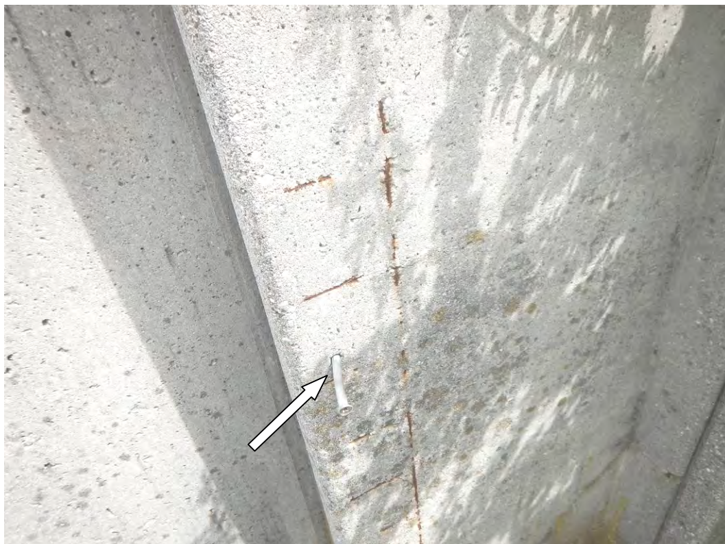
Slika 6: Na določenih mestih lamel so prisotni neodstranjeni vijaki
