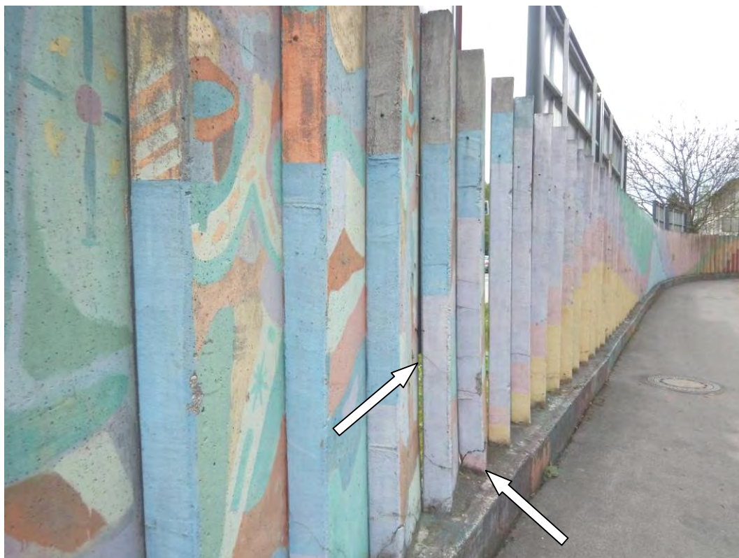
Slika 24: Na določenih lokacijah lamelne ograje so AB elementi deformirani oz. upognjeni izven svoje ravnine
