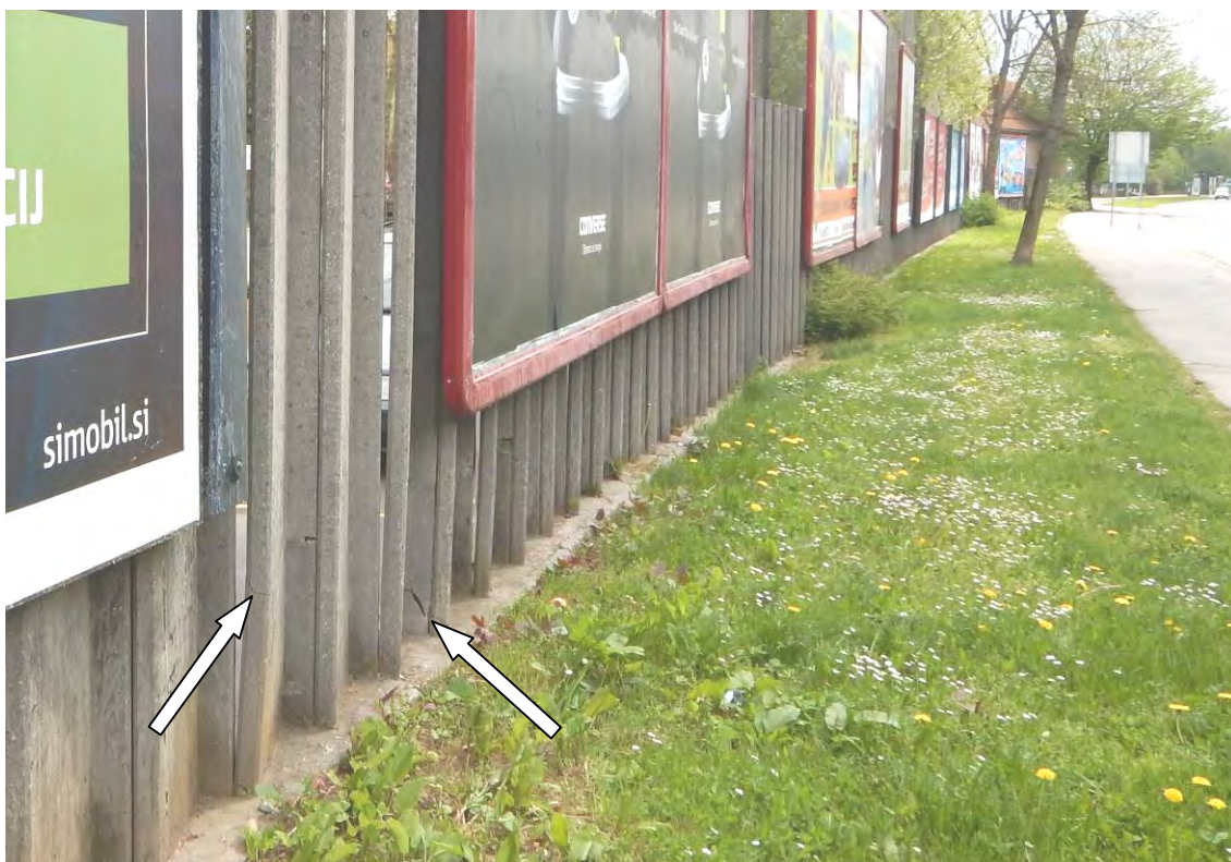
Slika 8: Na določenih lokacijah AB elementov je beton razpokan (konstrukcijske poškodbe)
