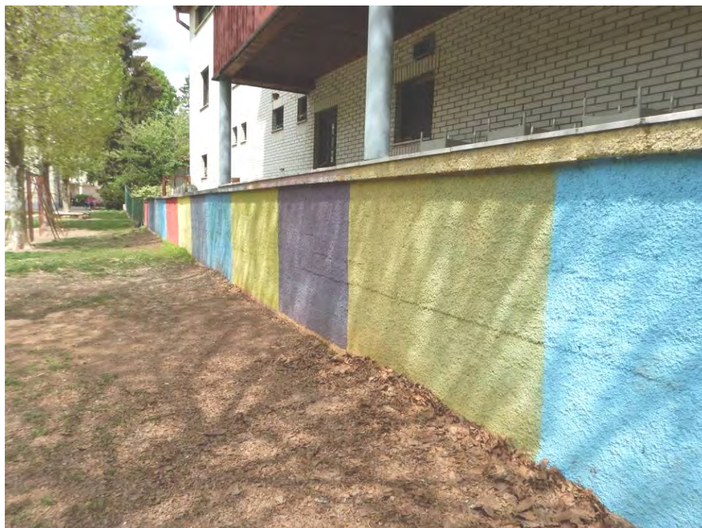
Slika 28: Obravnavana zidana ograja na notranji strani šolskega dvorišča
