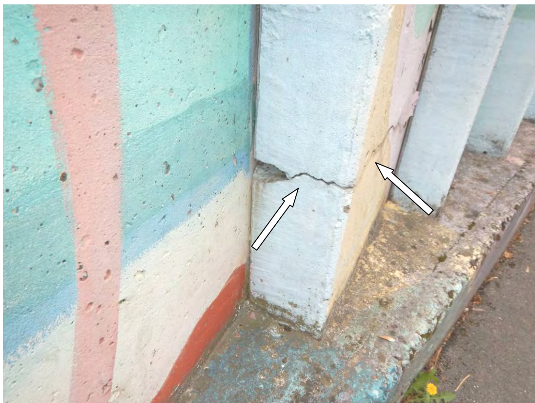
Slika 27: Na določenih lokacijah AB elementov je beton razpokan (konstrukcijske poškodbe)
