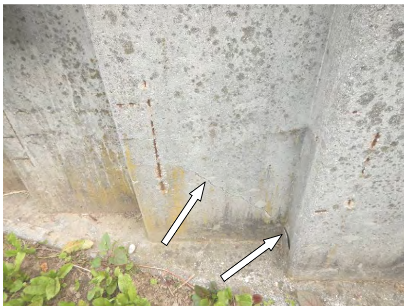
Slika 9: Na določenih lokacijah AB elementov je beton razpokan (konstrukcijske poškodbe)
