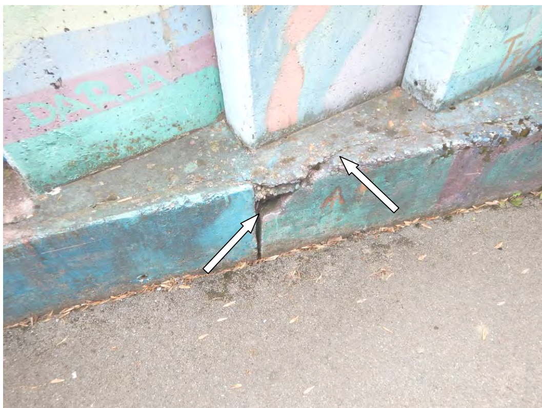
Slika 16: Vz dolž betonskega temelja, med betonskimi robniki, so vidni odprti stiki širine do max. 3 cm. Na določenih lokacijah temelja je beton odlomljen in odkrušen
