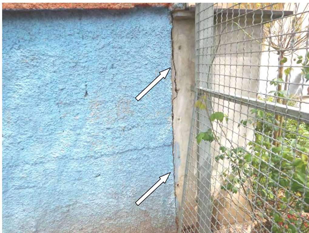
Slika 29: Na jugovzhodnem vogalu ograje je viden odprt delovni stik med zidano ograjo in sosednjim objektom
