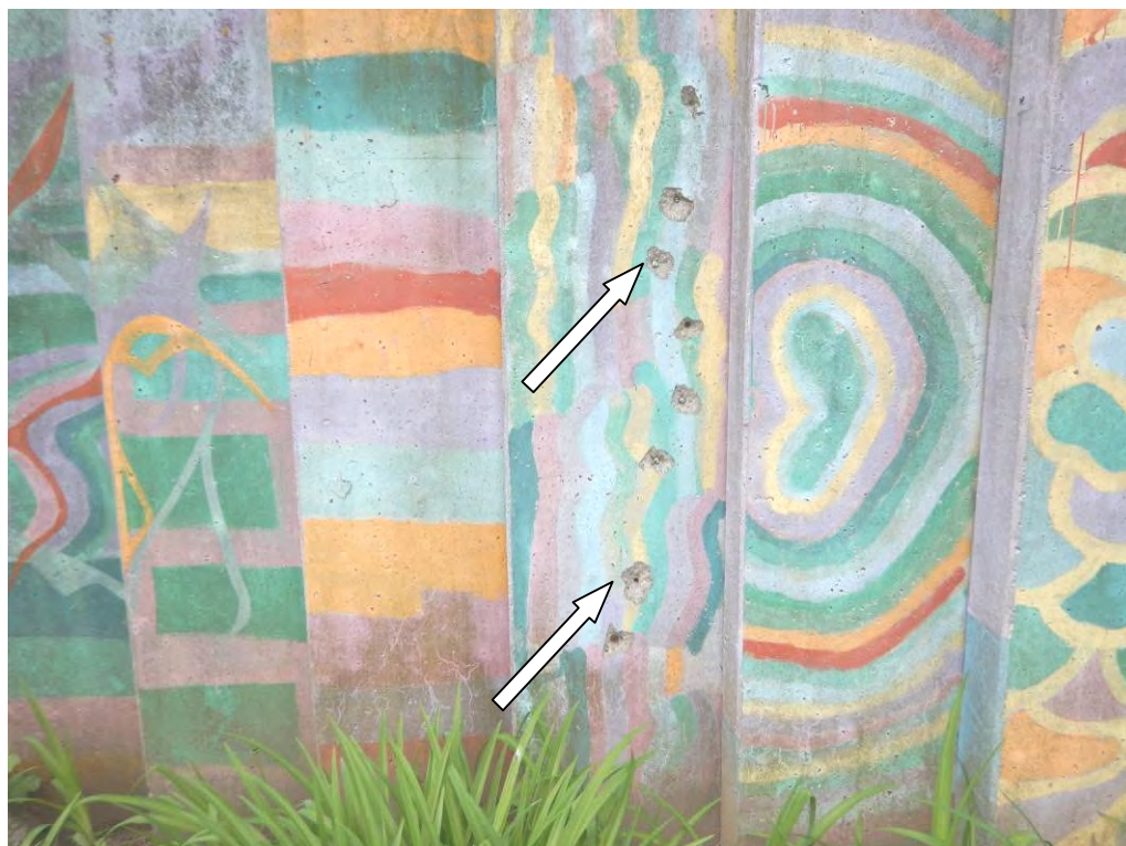
Slika 14: Mestoma so vidni preboji AB elementov z mehanskimi veznimi sredstvi
