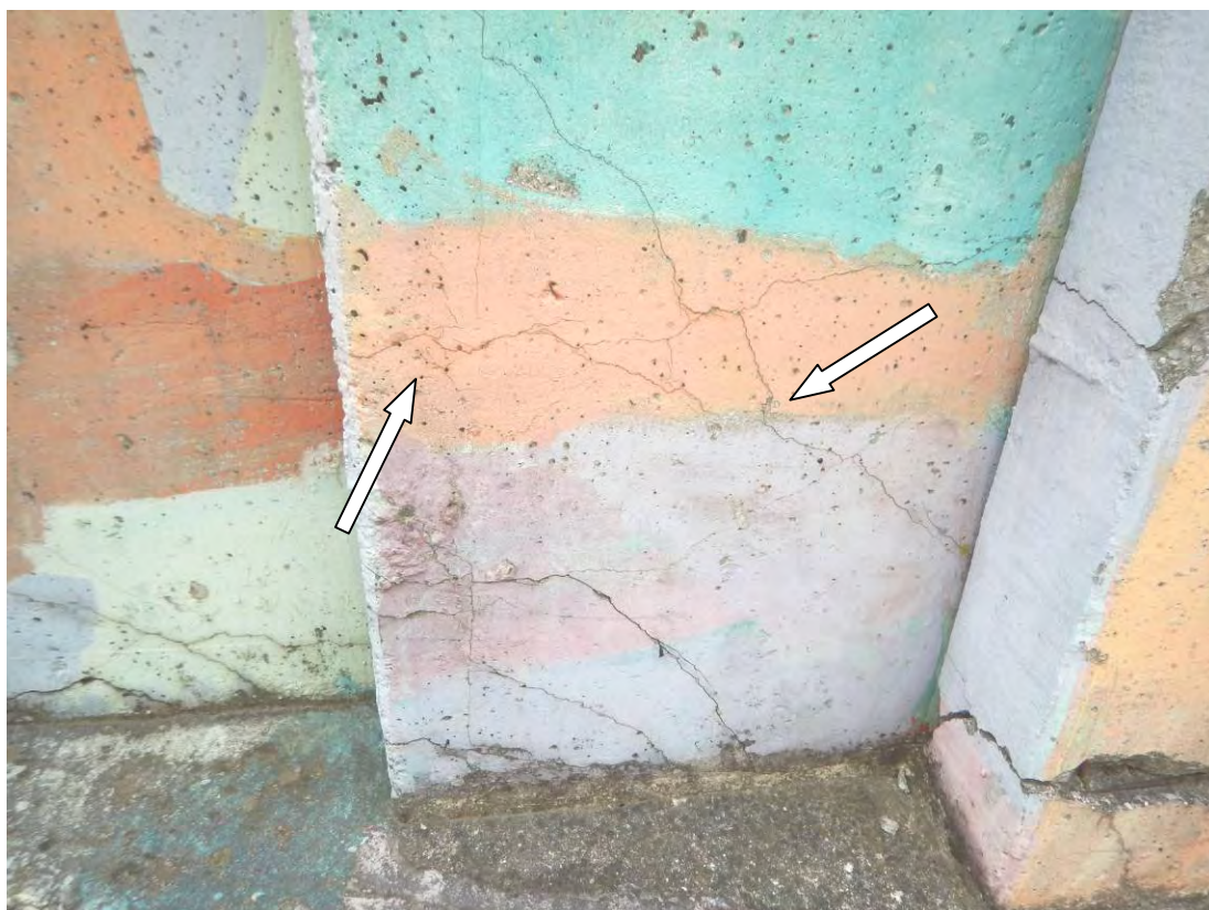
Slika 22: Mestoma so na površinah AB elementov vidne mrežaste razpoke
