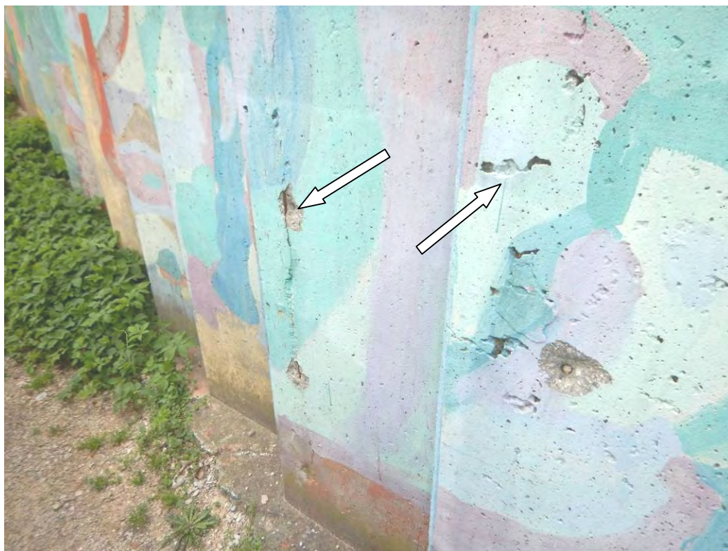
Slika 23: Mestoma je beton porozen. Na površinah AB elementov je vidna tudi korodirana armatura
