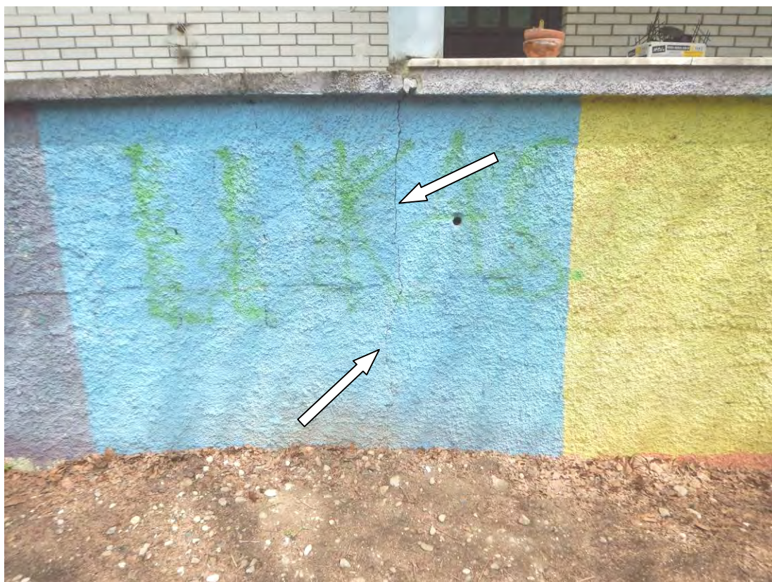
Slika 30: V območju naleganja betonskega stebra sosednjega objekta na zidano ograjo je vidna razpoka z vertikalno tendenco poteka
