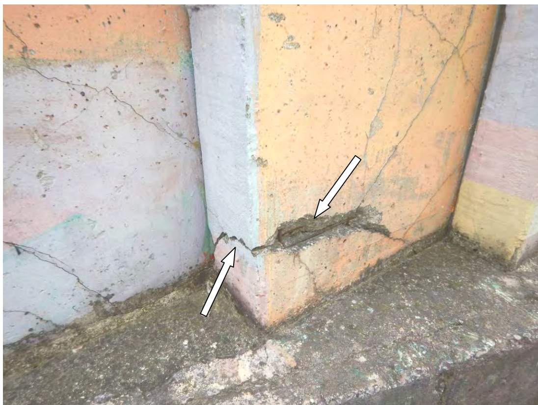
Slika 21: Na določenih AB elementih so prisotne konstrukcijske razpoke s horizontalno oz. diagonalno tendenco poteka. Mestoma je vidna tudi korodirana armatura
