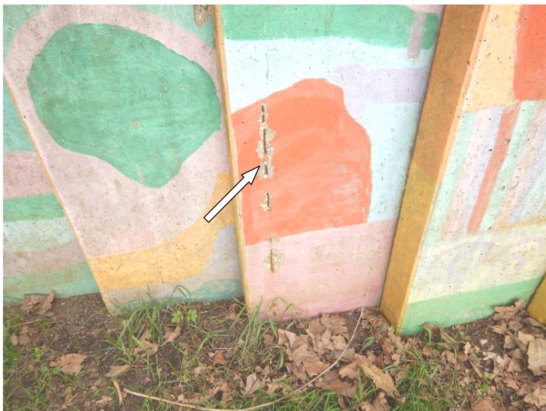
Slika 25: Na površini AB elementov je vidna korodirana armatura
