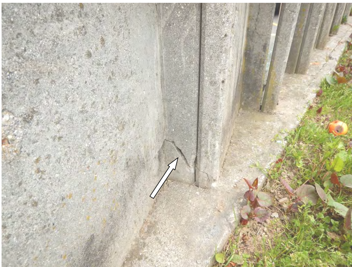
Slika 7: Na določenih lokacijah AB elementov je beton razpokan (konstrukcijske poškodbe)
