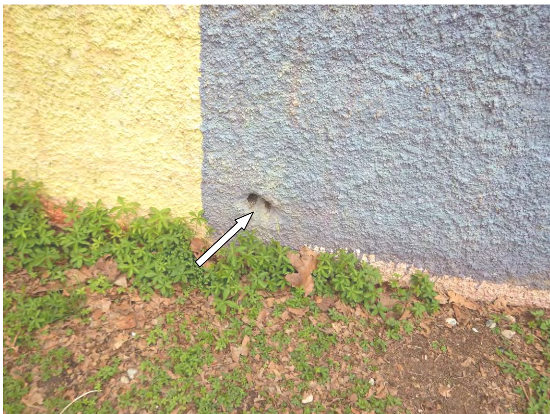
Slika 32: Mestoma so vidne poškodbe betonskih votlih zidakov
