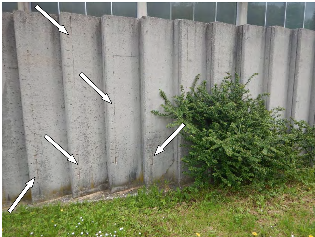
Slika 4: Praktično na vseh površinah AB elementov je prisotna korozija armaturnih palic in spremljajoče odpadanje zaščitnega sloja betona
