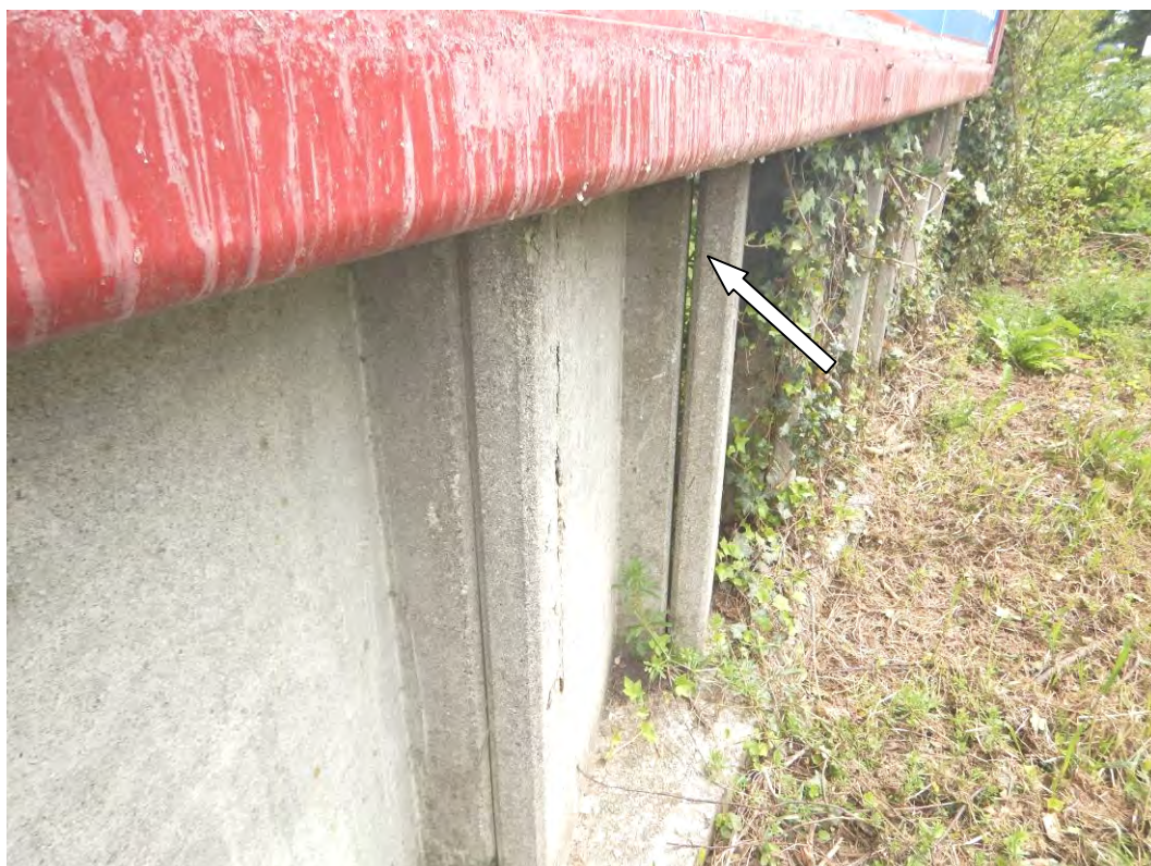
Slika 12: Na določenih lokacijah lamelne ograje so AB elementi močnejše deformirani oz. upognjeni izven svoje ravnine
