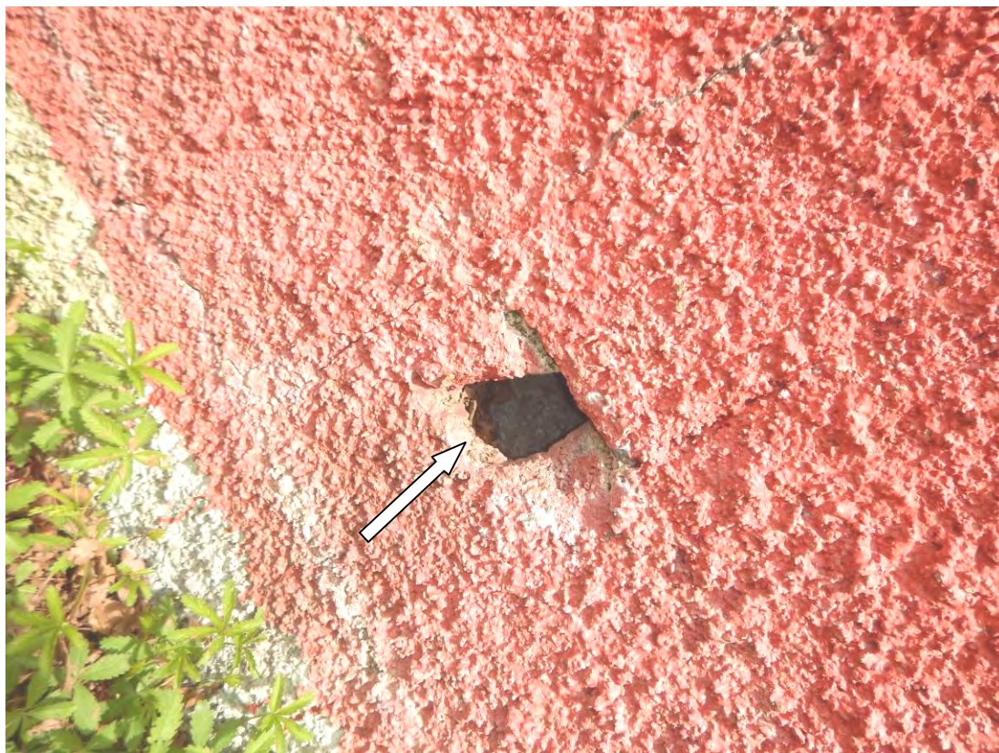
Slika 31: Mestoma so vidne poškodbe betonskih votlih blokov
