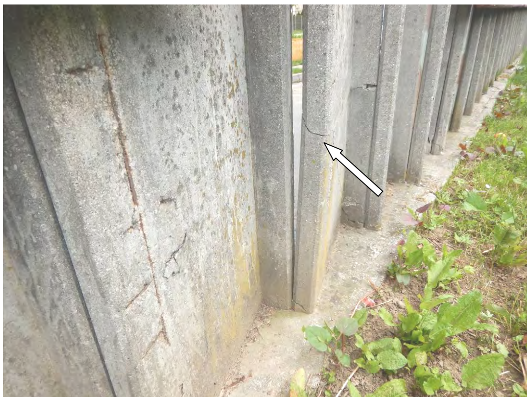
Slika 11: Na določenih lokacijah lamelne ograje so AB elementi močnejše deformirani oz. upognjeni izven svoje ravnine
