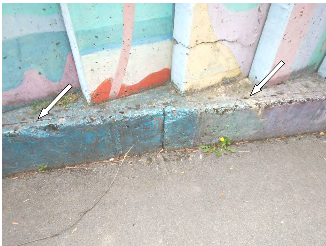
Slika 18: Vzdolž celotnega stika betonskega temelja in betonskih robnikov je viden odprt delovni stik povprečne širine ca. 1 cm
